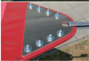
Eckenverstärkung mit Metallplatte
