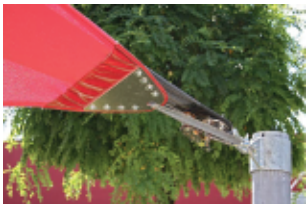
Anbindungselement Stahlmast mit höhenverstellbarer Hülse bzw. nach örtlicher Begebenheit
